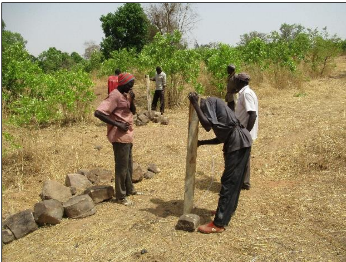
Figure 52. Les acteurs locaux utilisant le niveau à eau pour implanter les cordons pierreux (source : nos clichés mars 2019)
