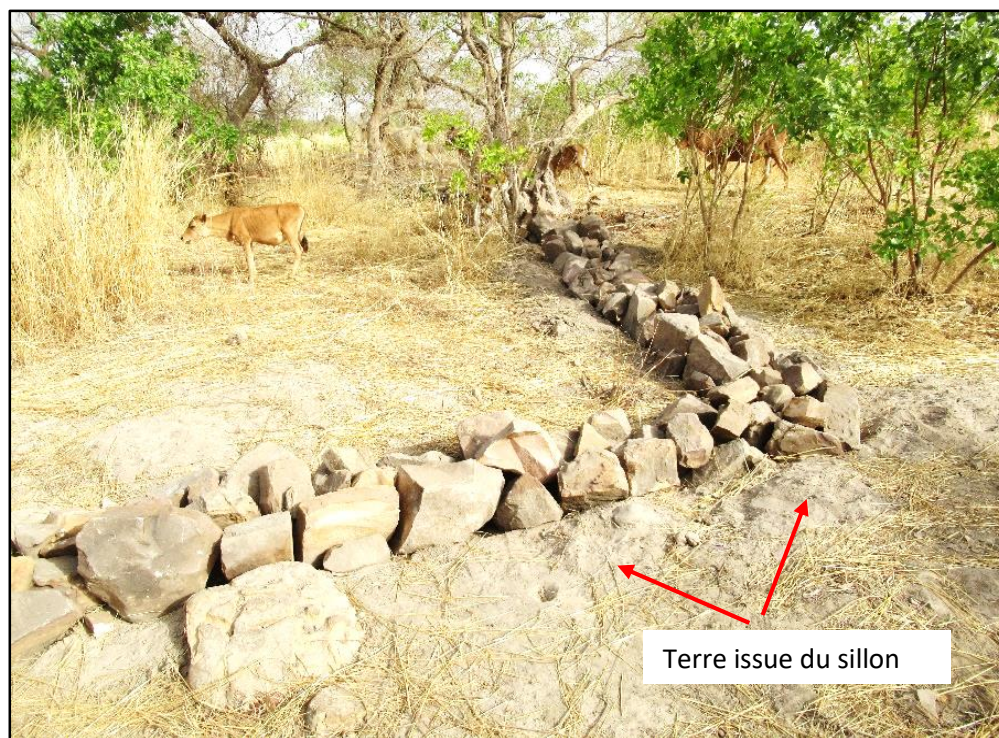
Figure 55. Disposition d'un cordon pierreux sur notre site d'expérimentation près du lac Wégnia (source : nos clichés, mars 2019).
