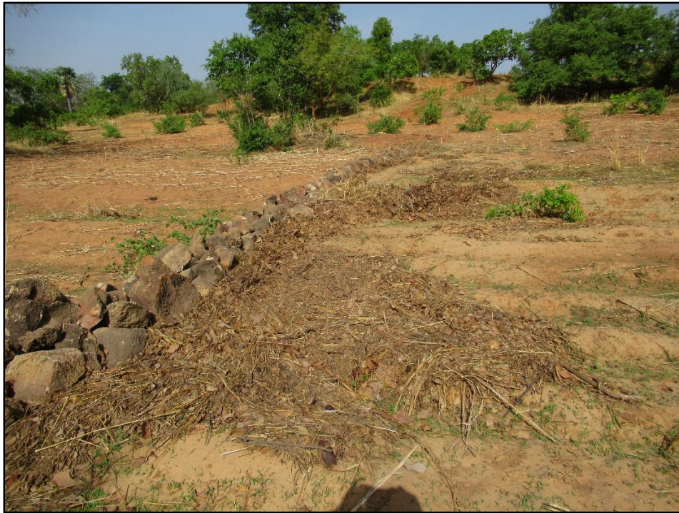
Figure 58. Rétention des feuilles d'arbres, des tiges de céréales, et d'autres débris par un cordon pierreux installé à environ 100 m du lac Wégna (source : nos clichés, mars 2020).
