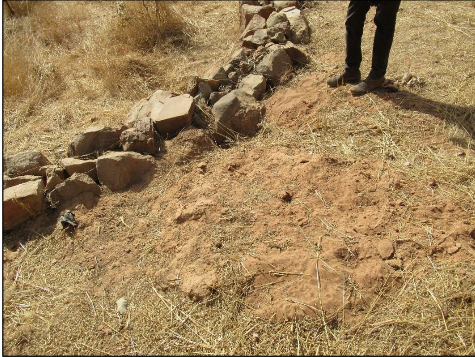
Figure 57. Des sédiments retenus par un cordon pierreux à environ 150 m du lac Wégna (source : nos clichés, mars 2020).
